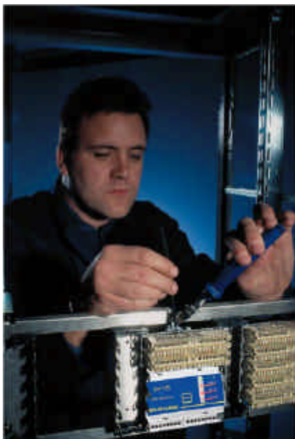
Instalarea intr-un panou
